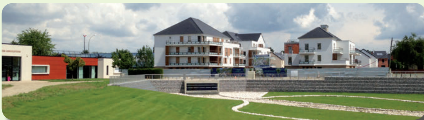
Bassin n° 3 de Vaux-le-Pénil - © CAMVS
